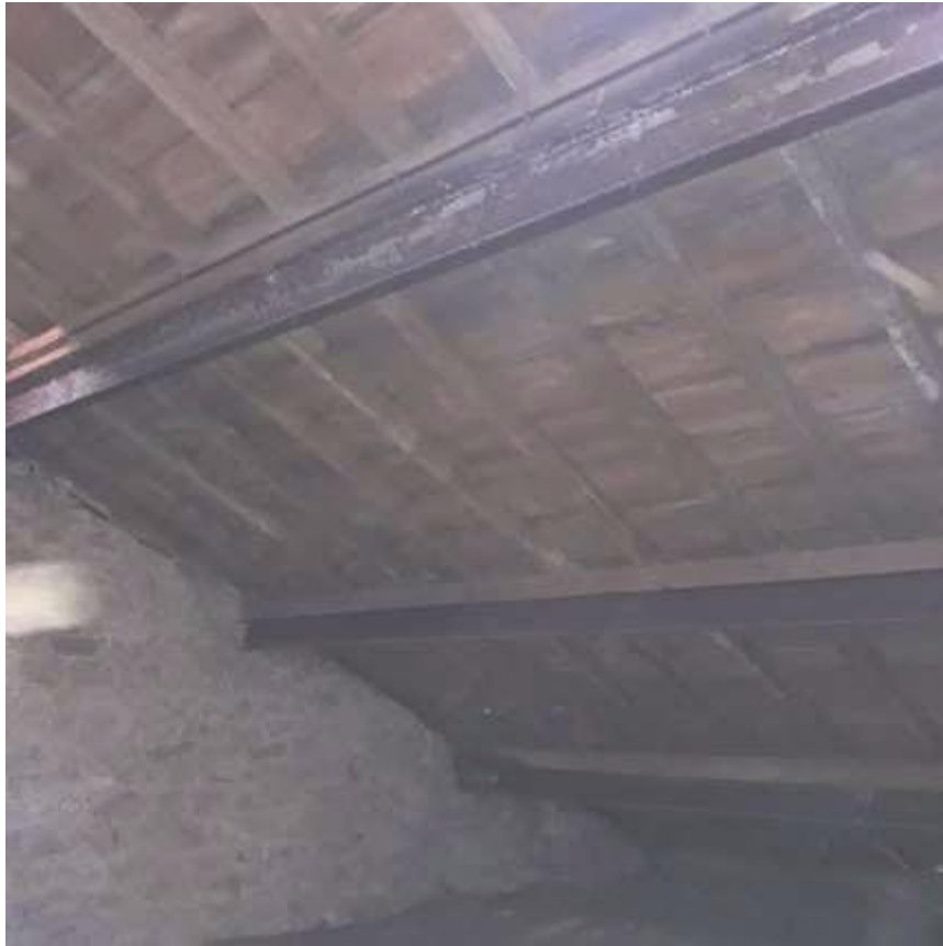
Combles perdus, tuiles existantes
